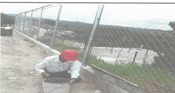
Foto 6: Repello de la terminación del cerco perimetral
