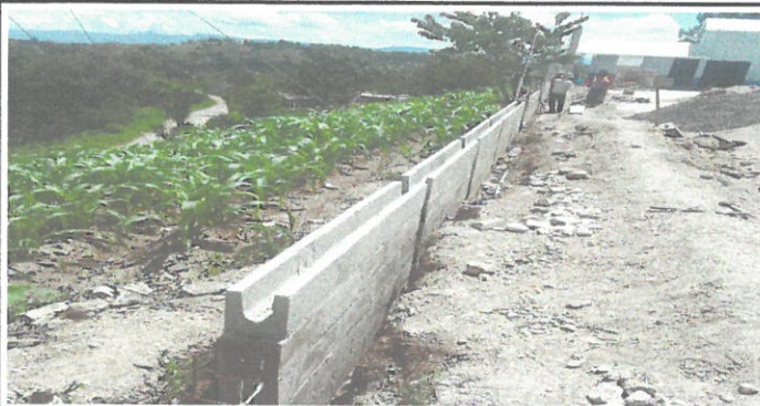
Foto 1: Instalación de block
