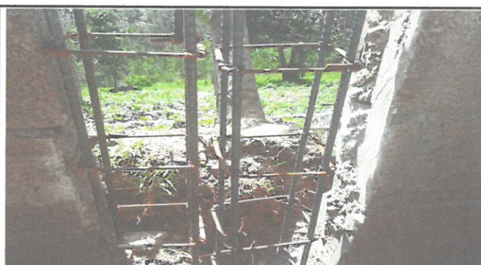
Foto 4: Instalación de columnas de por medio
