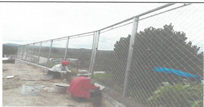
Foto 5: Terminación de cerco perimetral
