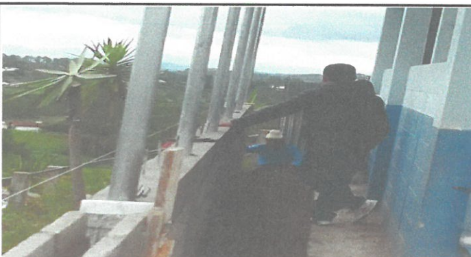
Foto 3: Colocación de tubos galvanizados
