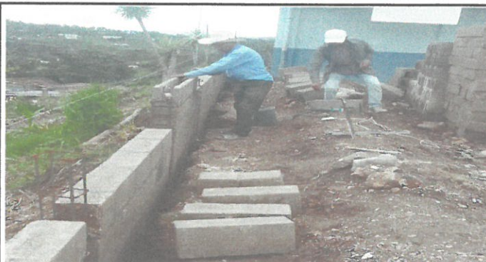
Foto 2: Colocación de cuarta hilada de block
