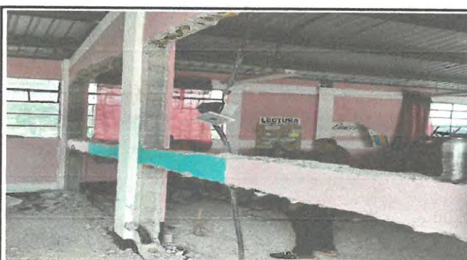
Foto 4: Ampliación del aula para tener más espacio
