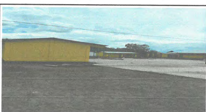
Foto 6: Terminación de pintada de toda la escuela
