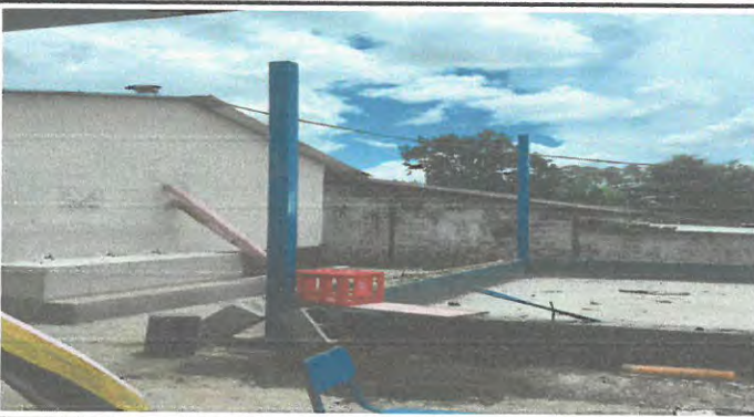
Foto 3: Columnas de metal y tres hileras de block.
