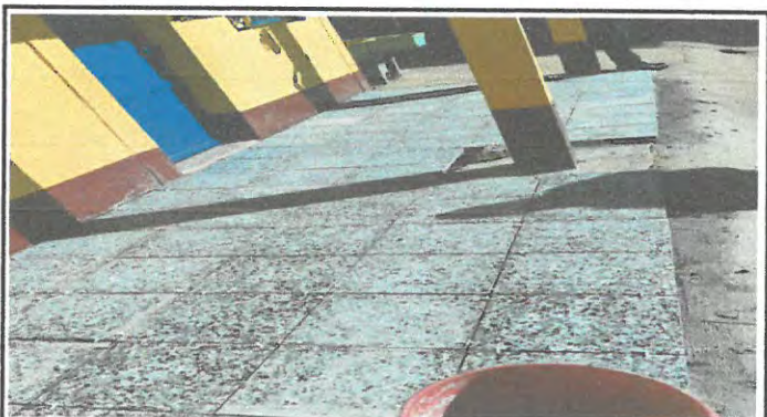
Foto 4: Colocación de piso en pasillo.
