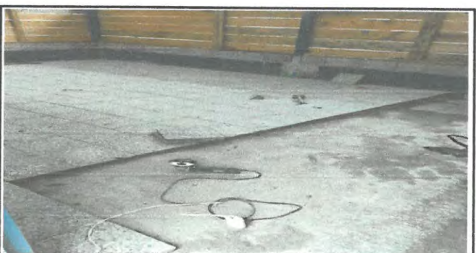
Foto 6: Colocación de piso en el aula.
