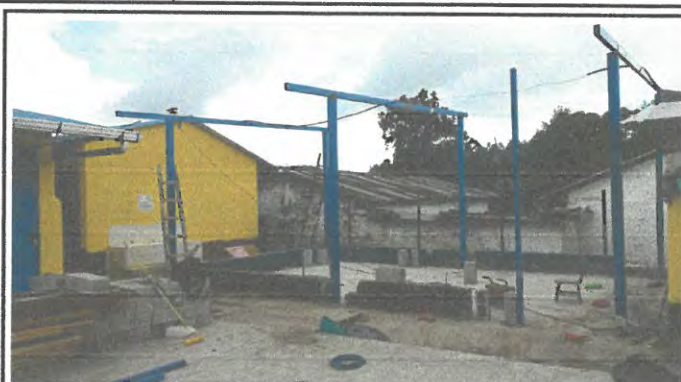
Foto 2: Paredes con estructura de metal
