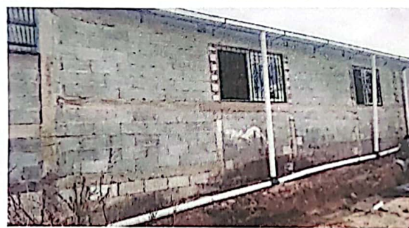
Canales nuevos instalados
