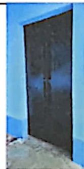
Puertas de todas las aulas pintadas
