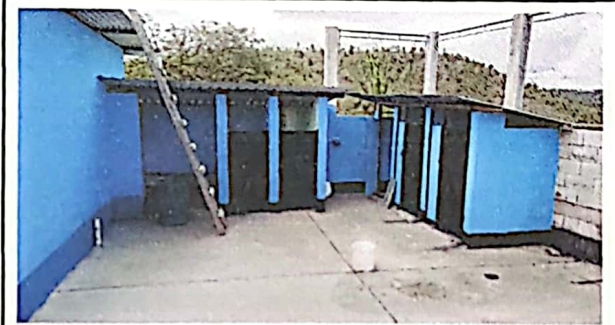
Baños remozados y pintados
