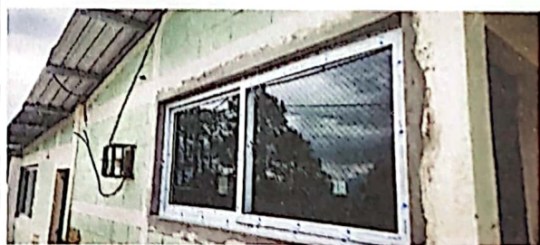
Parod remozado y instalación de una nueva ventana
