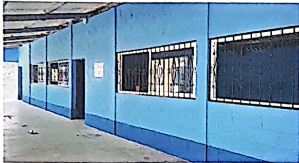
Ventanas nuevas de UPVC y balcones instaladas
