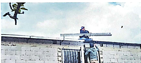
Instalación de nuevos canales
