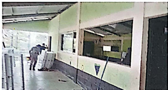
Sustitución de ventanas e instalación de nuevas
