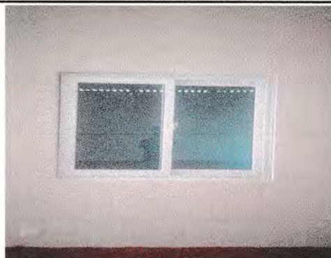
Foto 8: Levantamiento y colocacion de ventana.
