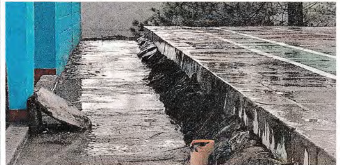
Foto 6: Mejoramiento de cuneta.
