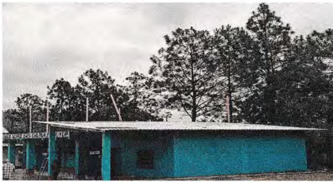
Foto1: Sustitucion de techo
