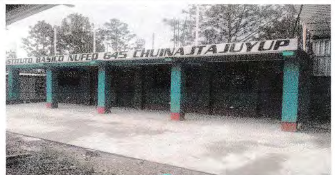
Foto 4: Mejoramiento de Patio
