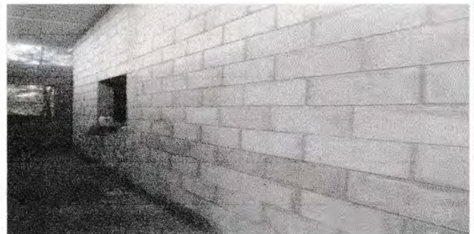
Foto 2: Remozamiento de aula, ampliacion de muro de 10 hileras de block
