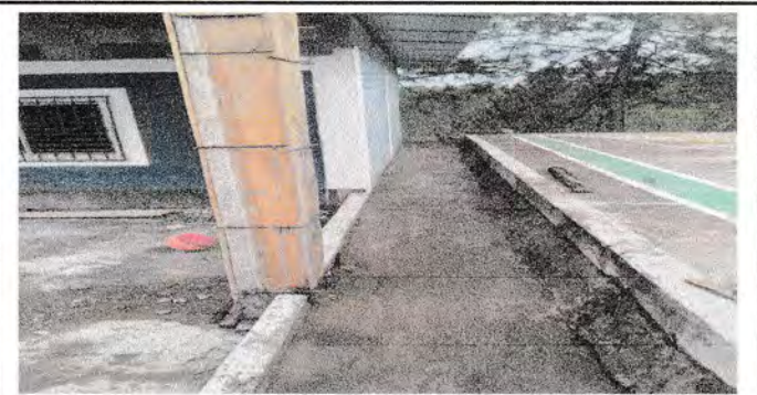
Foto 6: Mejoramiento de cuneta.
