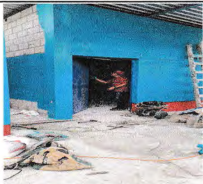
Foto 7: Sustitución de puerta de un aula y dos puertas de servicios sanitarios.
