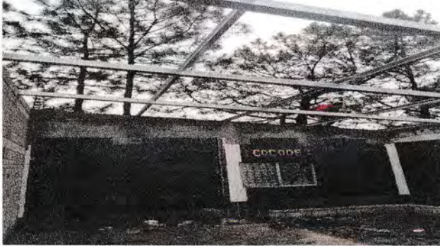
Foto1: Sustitucion de techo
