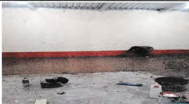
Foto 3: Sustitucion y nivelación de piso
