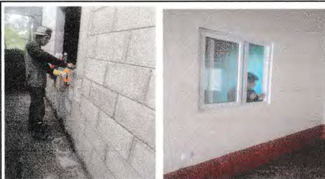
Foto 8: Levantamiento y colocación de ventana.
