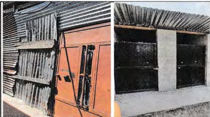
Foto7: Sustitucion de puerta de un aula y dos puertas de servicios sanitarios.
