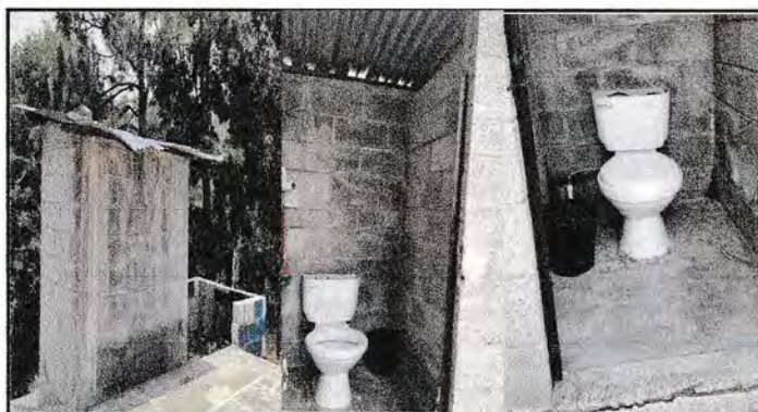
Foto 9: Sustitucion de laminas y costaneras, cambio de sanitarios y accesorios.
