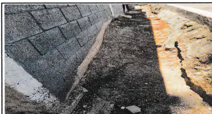
Foto 6: Mejoramiento de cuneta.
