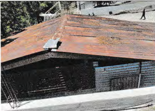
Foto1: Sustitución de techo
