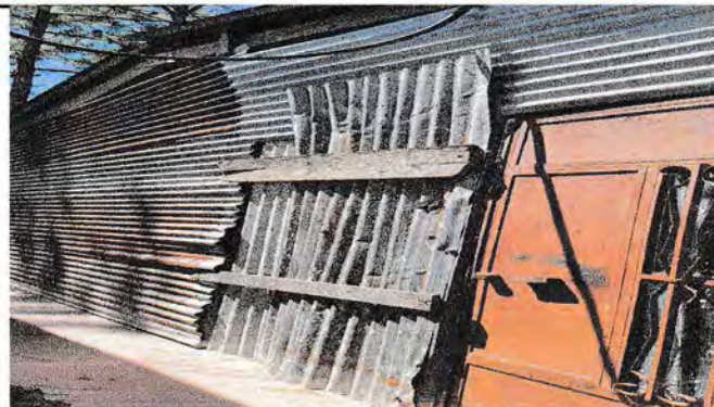
Foto 8: Levantamiento y colocacion de ventana.
