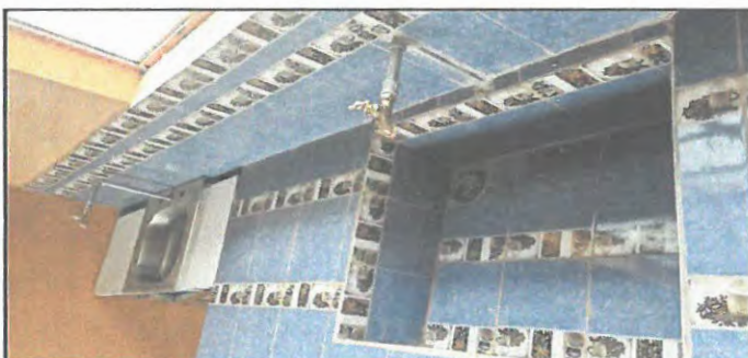
INSTALACION DE MESA Y LAVADEROS EN COCINA
