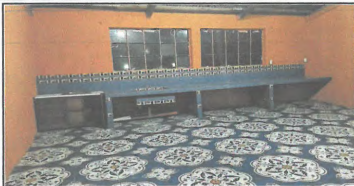
SUMINISTRO Y REPARACION DE COCINA ESCOLAR
