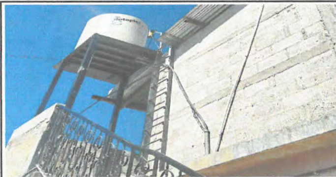
INSTALACION DE ROTOPLAS CON ESTRUCTURA METALICA
