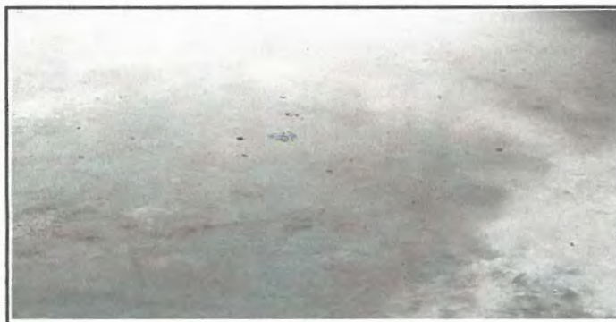
PISO EN LAVANDERIA
