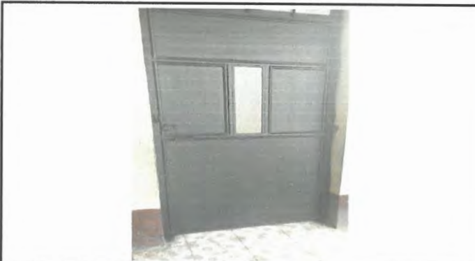
Puertas pintadas y reparadas.
