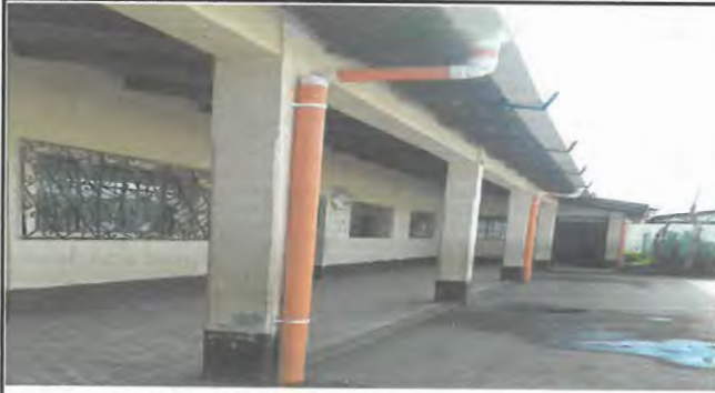
Canales y bajadas de agua instaladas en techo de aulas existentes.
