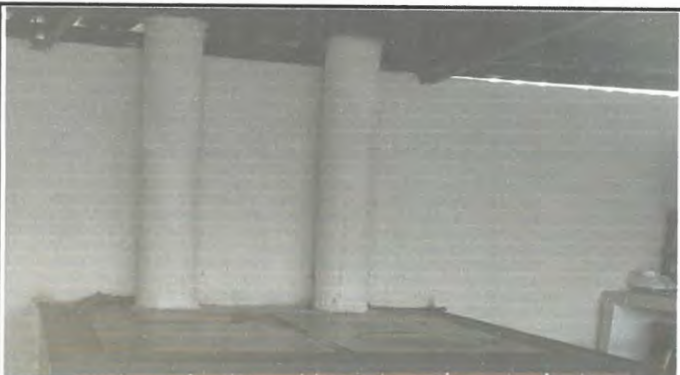
Cambio de chimeneas en cocina con tubos de concreto prefabricados en cocina.
