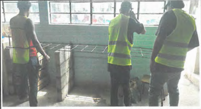
Fabricacion de mesa de concreto para cocina.
