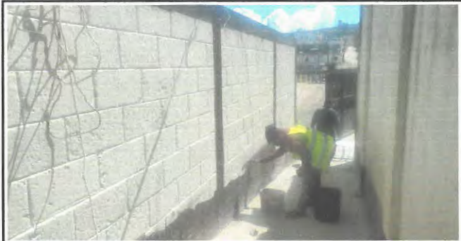
Aplicación de pintura en muro perimental exterior.
