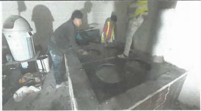
Instalando juego completo de ornillas en plancha de leña en cocina.
