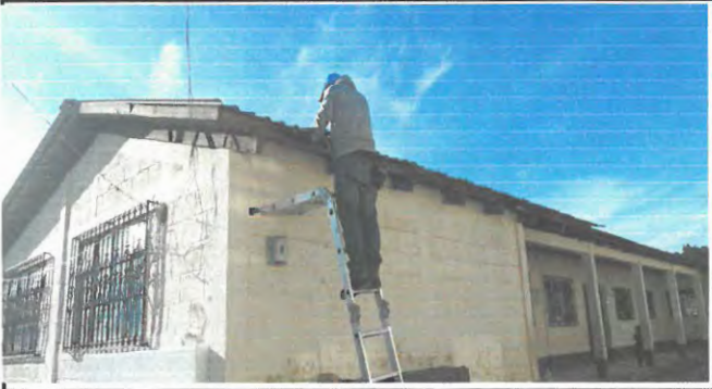
Realizando cambio de instalación de linea electrica principal en modulo 2 de la escuela.
