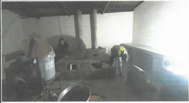
Instalando azulejos en entorno de plancha de leña en cocina.
