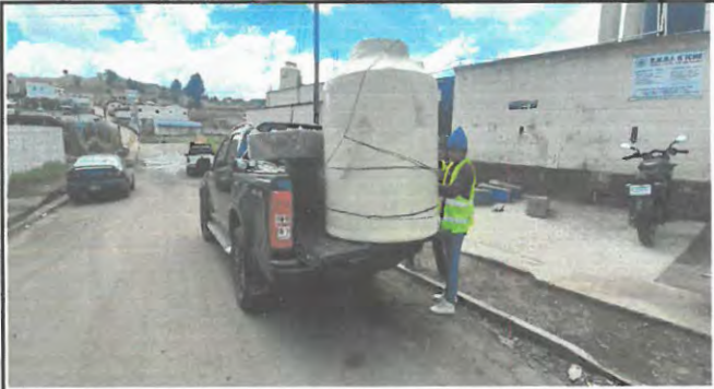
Deposito de agua de Politileno de 1,100 litros a instalar sobre terraza.
