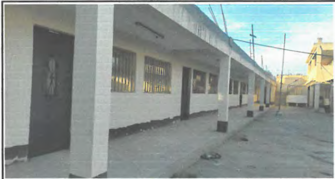
Cenefa en colocación en modulo 2 en escuela.
