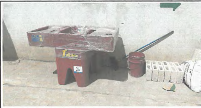
Pila plástica de dos lavaderos a instalar en cocina
