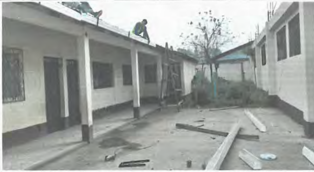
Colocación de canaletas y bajadas de agua en módulo 2 de la escuela.
