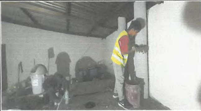
Instalando tubos de concreto para chimeneas en plancha de leña en cocina.
