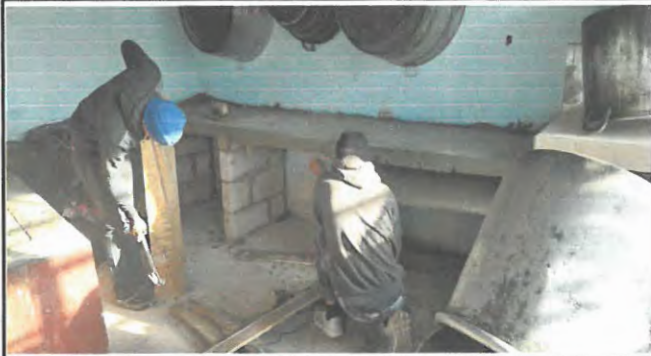
Fabricando mesa de concreto en cocina.
