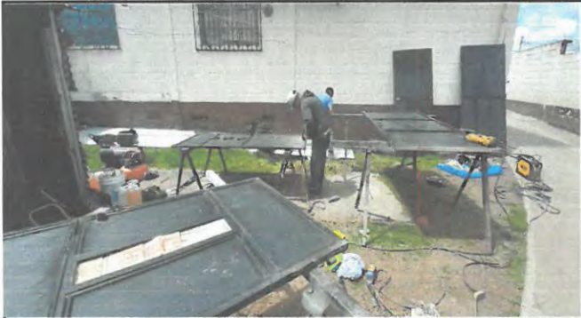
Realizando reparación y mantenimiento de puertas
