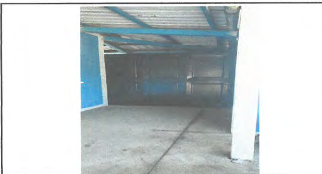
Foto 5: Colocación de puerta corrediza
