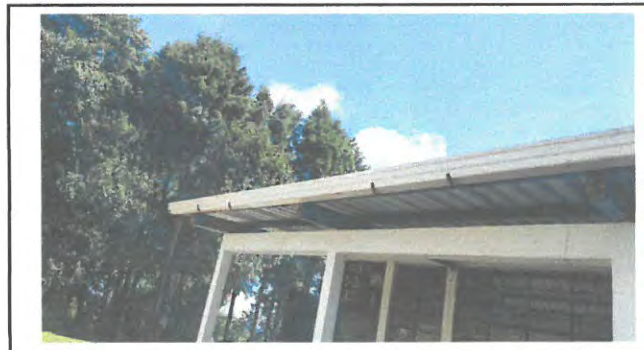
Foto 6: Colocación de canaletas en techo
