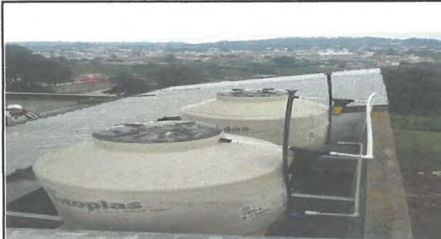
Foto 2: Instalación de 2 depósitos de agua sobre los techos y canaletas.
