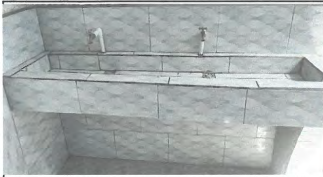
Foto 1: Baño de señoritas: instalación de azulejo en piso y paredes, lavamanos de concreto, reemplazo de inodoros, plomería completa.
