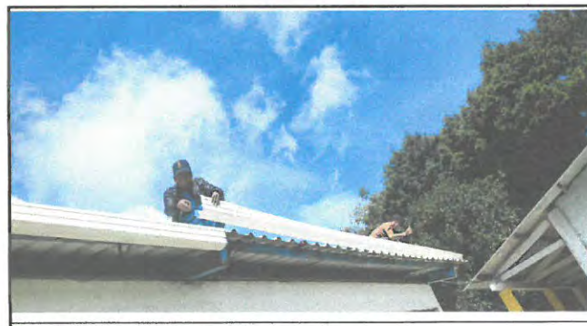
Foto 6: Colocación de canaletas en techo
