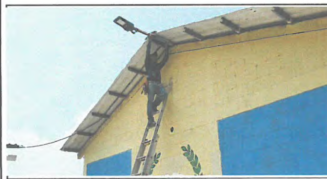
Foto 5: Instalación de lámparas solares módulo 1
