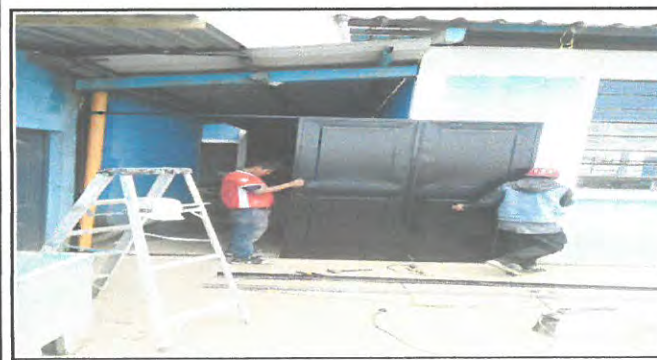
Foto 5: Colocación de puerta corrediza
