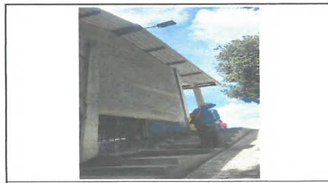
Foto 6: Instalación de lámparas solares módulo 2
