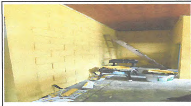
Foto 4: Pintura de módulo 1, vista interior
