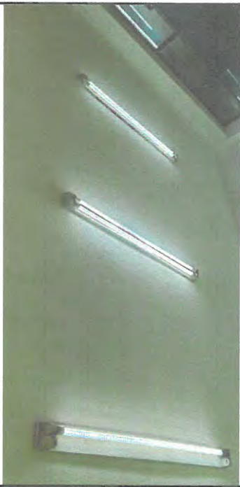
Foto 54: INSTALACION DE LAMPARAS
