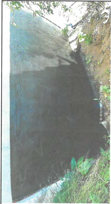
Foto 39: REPARACIÓN Y REPELO DE PARED
