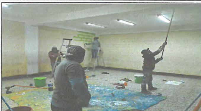
Foto 26: Suministro de pintura interior y exterior
