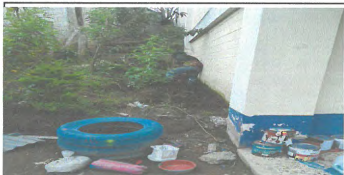
Foto 22: Reparación de repello de pared.
