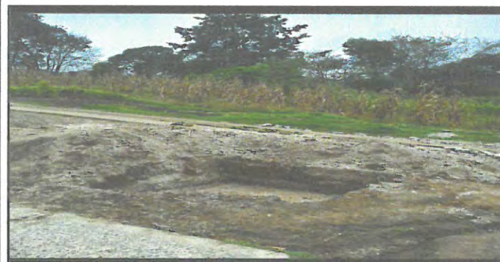
Foto 23: Reparación de caja de drenaje
