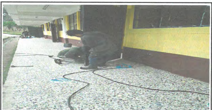
Foto 29: Reparación de chapas y pintura de puertas
