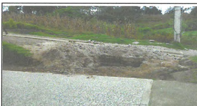
Foto 24: Reparación de caja de drenaje
