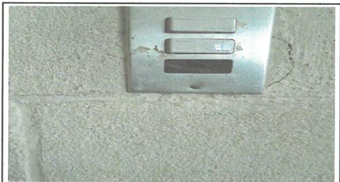
Foto 27: Reparación o sustitución del sistema electrico
