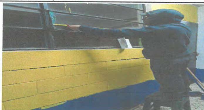
Foto 32: Reparación de ventanas
