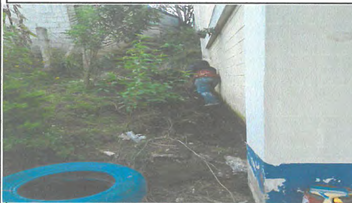
Foto 21:Reparación de repello de pared
