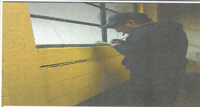
Foto 31: Reparación de Ventanas
