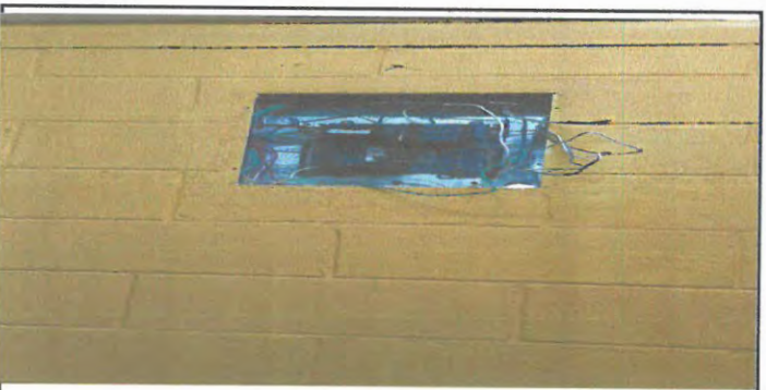
Foto 35 INSTALACIÓN DE LAMPARA
