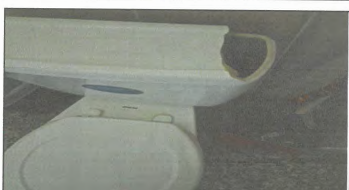
Foto 34: Reparación de Lavamanos/sanitarios.
