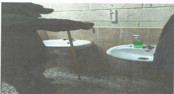
Foto 33: Reparación de Lavamanos/Sanitarios
