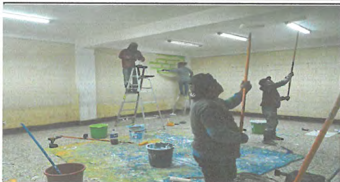
Foto 25: Suministro de pintura interior y exterior.
