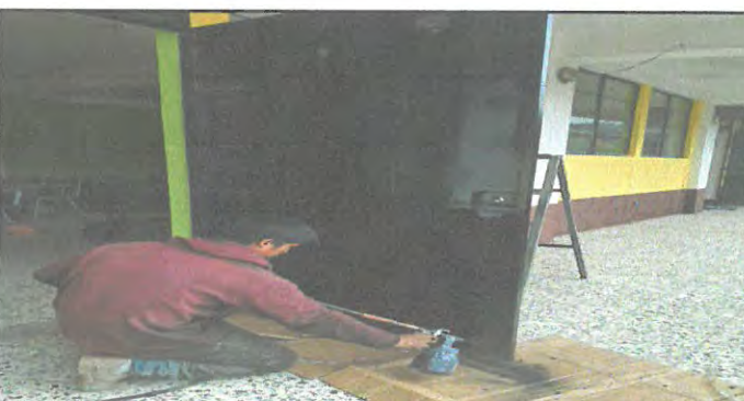
Foto 30: Reparación de Chapas y pintura de puertas
