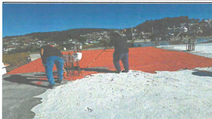
Foto 20:Impermiabilización de terraza
