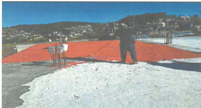
Foto19:Impermiabilización de terraza.
