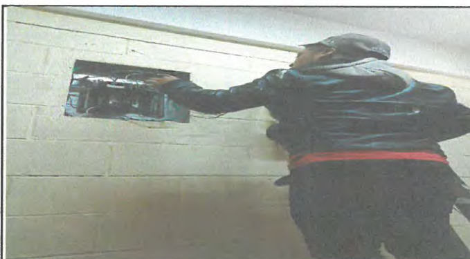
Foto 28: Reparación o sustitución del sistema electrico.
