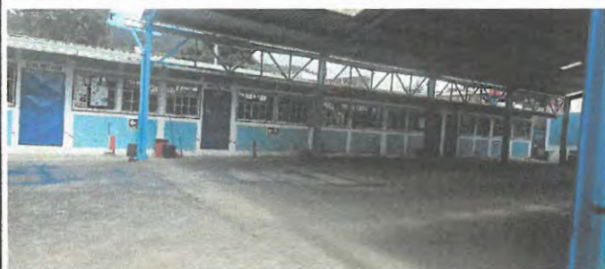
Foto 7: vista de nueve puertas pintadas y finalizadas
