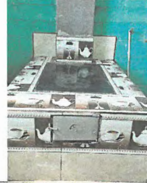
Foto 2: vista de plancha trabajo terminado
