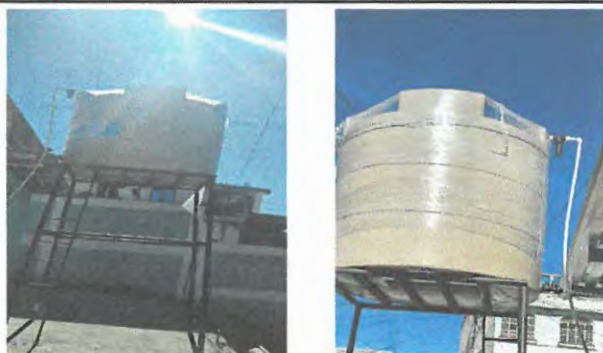
Foto 11: Vista Colocacion de depósito de agua de 1700 litros.
