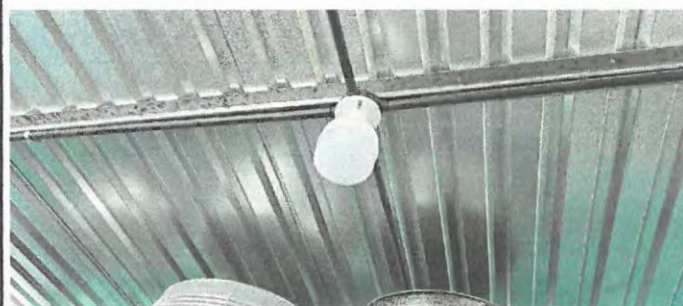
Foto 9: Instalación de energía eléctrica
