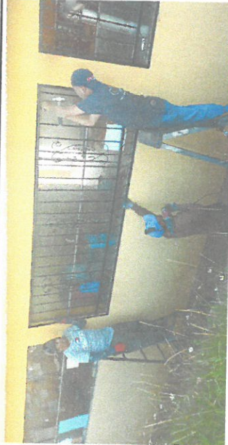
Foto 5: Fabricación e instalación de balcones de hierro en ventanas
