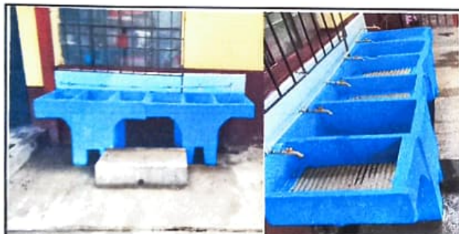
AREA DE LAVADEROS DE NIÑOS CAMBIO DE PILA Y REPARACION DE PISO
