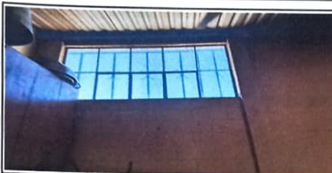
PAREDE DE COCINA DONDE SE INSTALARA VENTANA CON BALCON
