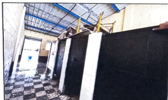
MANTENIMIENTO Y ENGRASE A PUERTAS DE METAL DEL BAÑO DE NIÑOS
