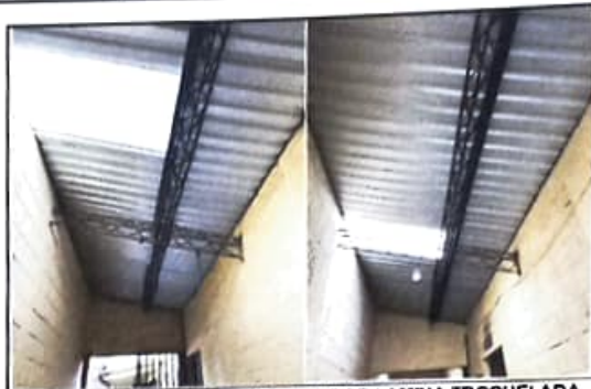
CAMBIO DE TECHO TIPO DURALITA POR LAMINA TROQUELADA EN EL AREA DE LOS PACIOS
