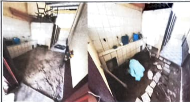
INSTALACION DE DRENAJE EN EL AREA DE NIÑOS E INSTALACION DE REPOSADERAS CON CONECCION A DRENAJE MAS CERCAÑO
