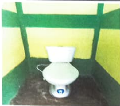
Culminación de cambio de servicio sanitario.
