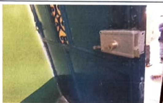
Culminación de cambio de chapa.
