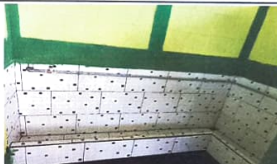
Terminación de Minjitorio
