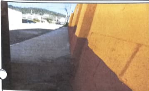
Culminación de banqueta exterior
