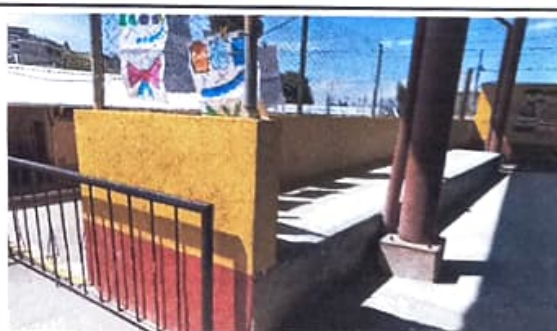
Culminación de muro perimetral.
