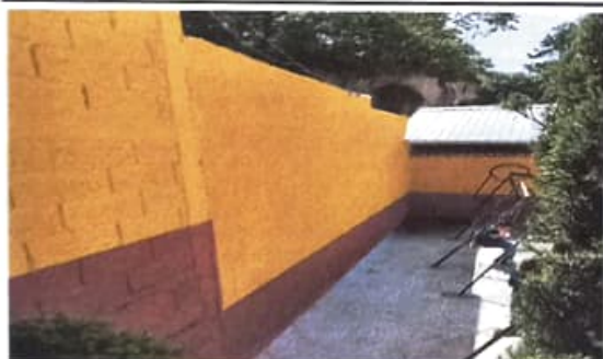
Culminación de repello y semido de pared
