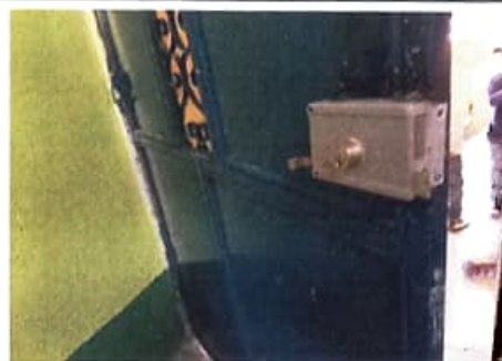
Proceso de reparacion de chapa
