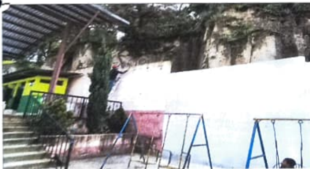
Proceso de ejecución de repello interior al patio
