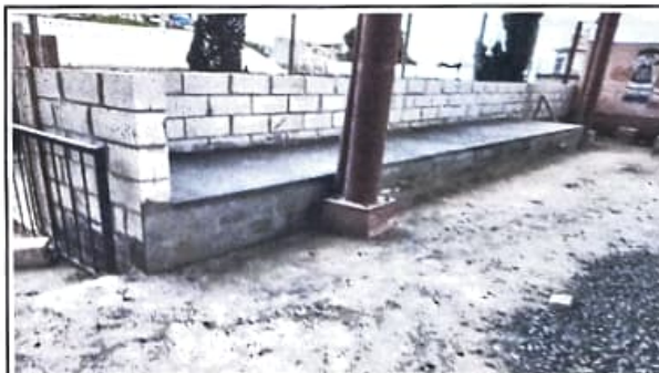
Proceso de ejecución de banqueta de muro
