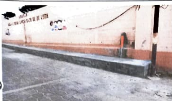
Proceso de ejecución banqueta exterior
