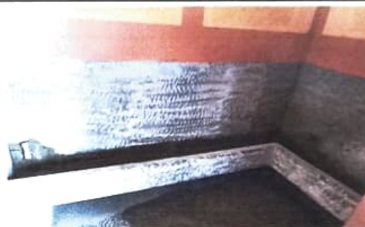
Proceso de ejecución de Minjitorio
