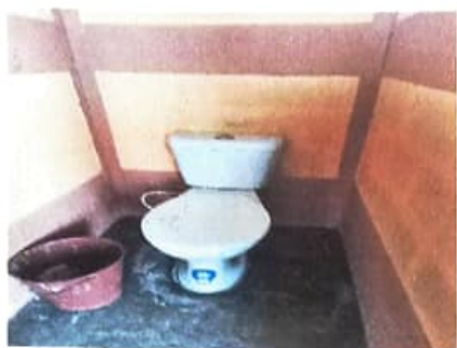
Cambio de servicio sanitario.
