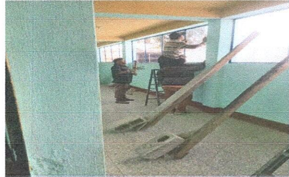
Foto 2: INSTALACION DE VIDRIERAS
