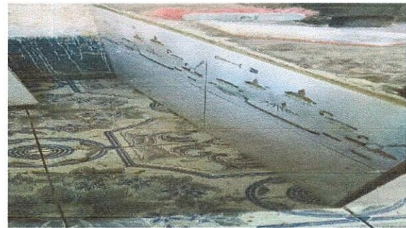
Foto 4: COLOCACION DE AZULEJO A PLANCHA
