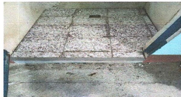
Foto 6: INSTALACION DE TAZAS SANITARIAS
