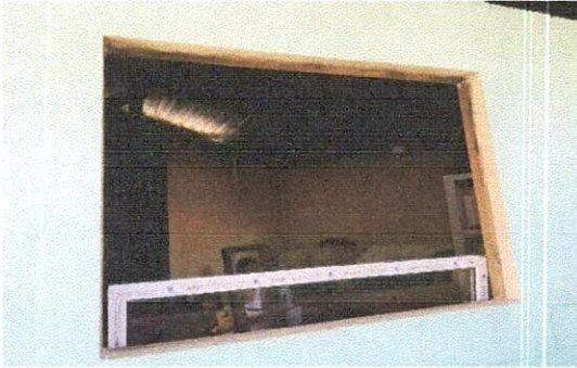
Foto 1: INSTALACION DE VENTANA
