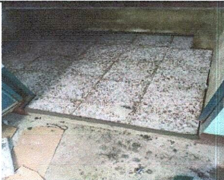
Foto 3: COLOCACION DE PISO GRANITO
