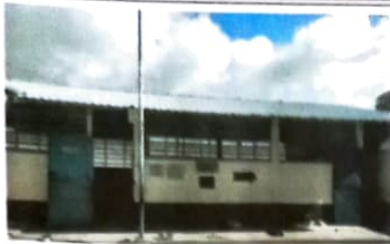
Cambio de lámina por lámina troquelada aluzinc calibre 26 para dos aulas
