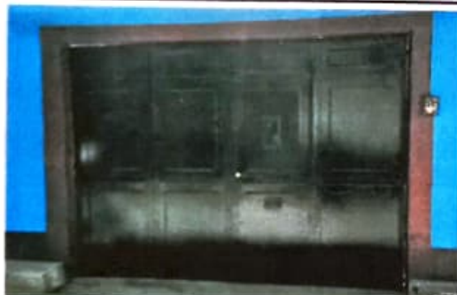
Sustitución de portón de Metal
