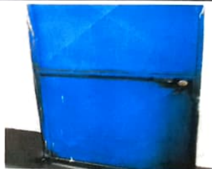
Sustitución de chapas
