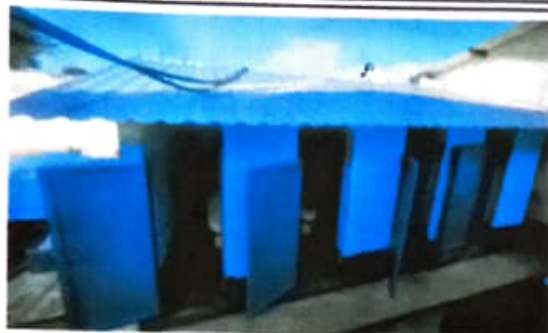
Mantenimiento a estructura, aplicación de pintura a puertas de servicios sanitarios
