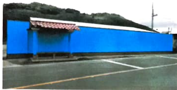
Pintura en muros exteriores
