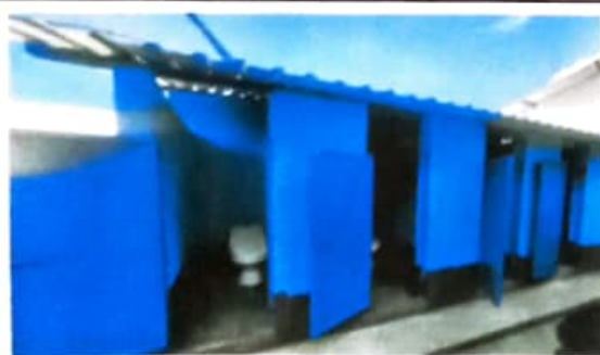
Sustitución de inodoros
