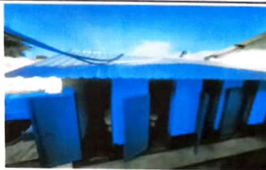
Cambio de lámina por lámina troquelada aluzinc calibre 26 para servicios sanitarios
