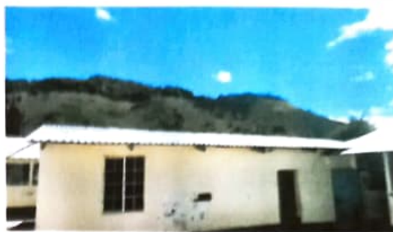
Cambio de lámina por lámina troquelada aluzinc calibre 26 para dirección, laboratorio de computación y bodega
