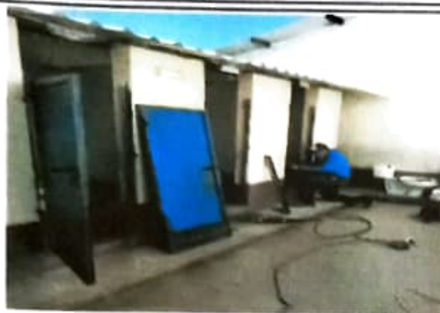
Mantenimiento a estructura, aplicación de pintura a puertas de servicios sanitarios
