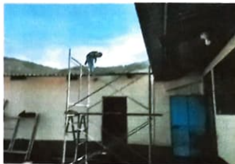
Cambio de lámina por lámina troquelada aluzinc calibre 26 para dirección, laboratorio de computación y bodega
