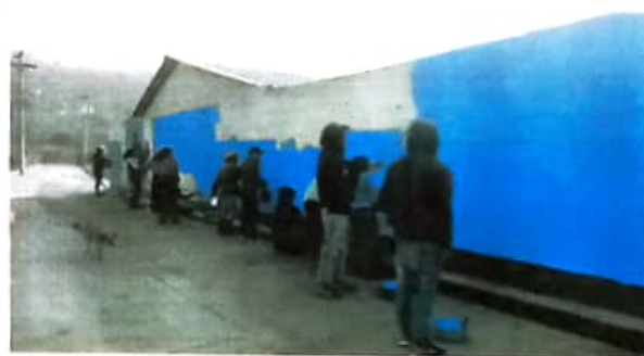
Pintura en muros exteriores
