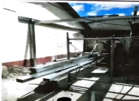
Cambio de lámina por lámina troquelada aluzinc calibre 26 para galera de cocina
