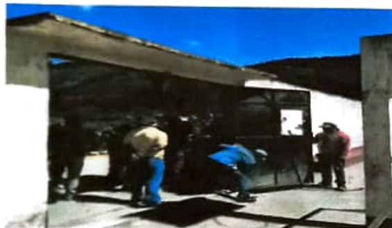
Sustitución de portón de Metal
