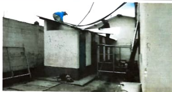
Cambio de lámina por lámina troquelada aluzinc calibre 26 para servicios sanitarios
