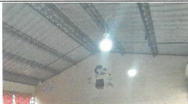
Foto 11: Sustrucción de lámparas
