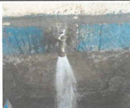
Foto 8: Sustrucción de glifo
