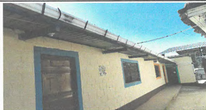
Foto 12: Cambio del cableado eléctrico
