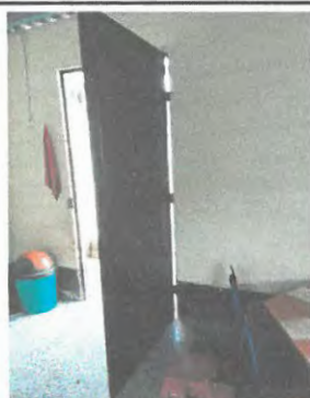
Foto 9: Mantenimiento a estructura de puertas.
