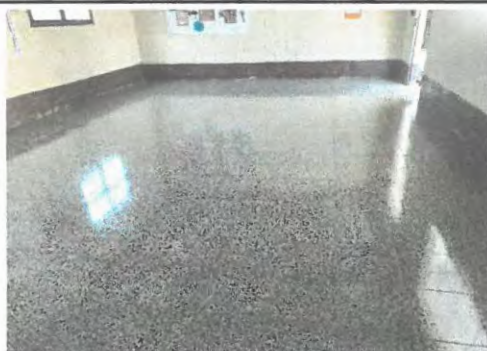
Foto 5: Cambio de piso
