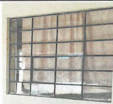
Foto 4: Sustitución de vidrios
