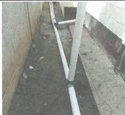
Foto 1: Sustitución de tubos de agua pluvial.
