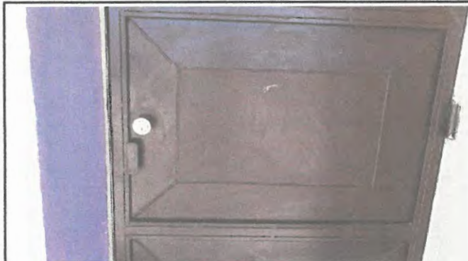
Foto 7: Sustrucción de chapas.
