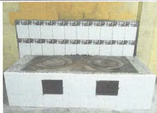
Foto 2: Sustitución de chimenea de cocina
