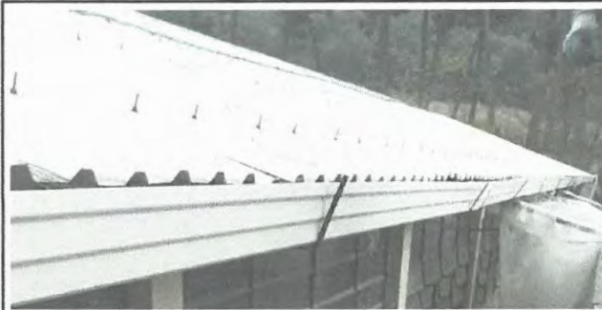
Foto 6: Sustitución de canaletas
