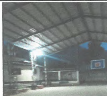
Foto 10: Cambio del cableado eléctrico
