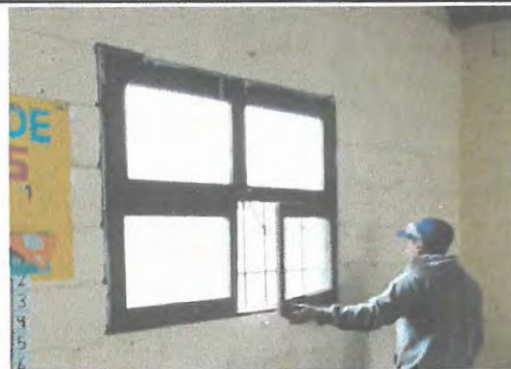
Foto 4: Sustitución de vidrios
