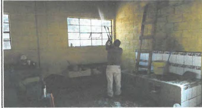
Foto 2: Sustitución de chimenea de cocina
