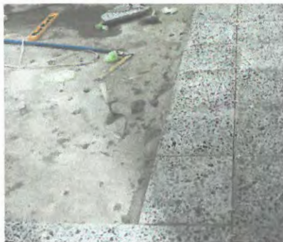
Foto 5: Cambio de piso
