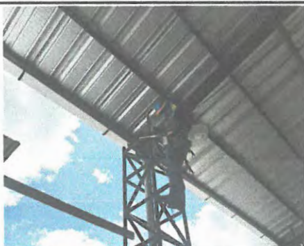
Foto 11: Sustitución de lámparas
