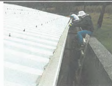
Foto 6: Sustitución de canaletas
