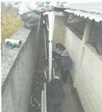
Foto 1: Sustitución de tubos de agua pluvial.
