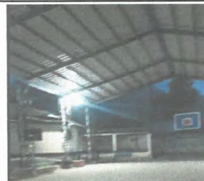
Foto 10: Cambio del cableado eléctrico
