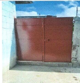
Foto 2: colocación de puerta principal.
