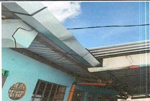
Foto1: Colocación de canal de metal
