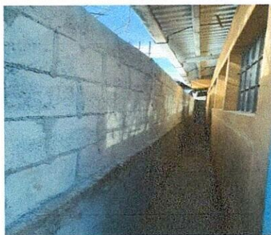
Foto 3: Finalización del muro perimetral de block y columnas.
