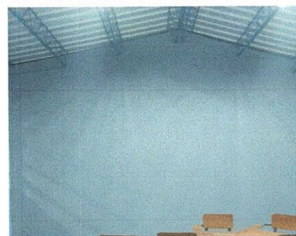
Foto 6: Impermeabilización de pared.
