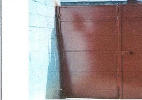
Foto 2: Proceso de colocación de puerta..
