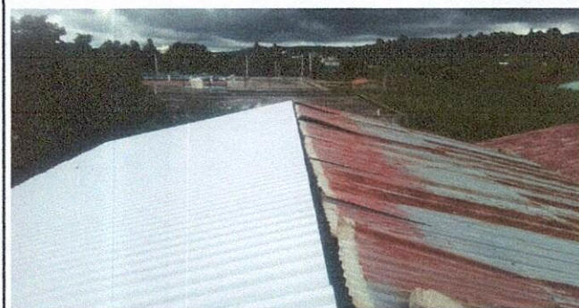
Foto 4: Proceso de cambio de lámina, por lámina troquelada aluzinc calibre 26 y sustitución de capote de lámina para lámina troquelada.
