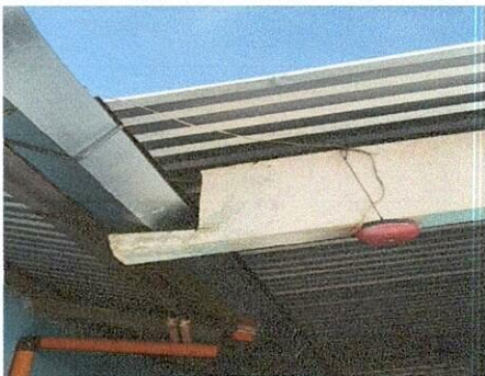
Foto 1: Proceso de cambio de canal de metal
