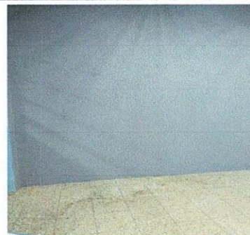
Foto 6: Proceso de impermeabilización de pared.
