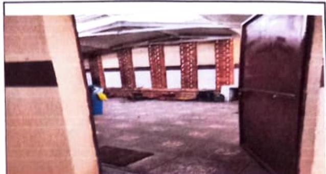
COLOCACIÓN DE PISO EN COCINA TERMINADO
