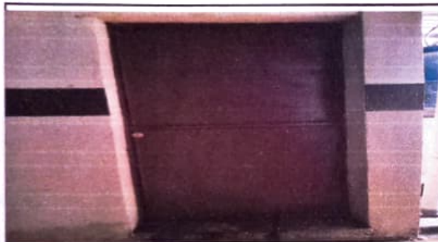
VISTA DE PUERTA DE COCINA
