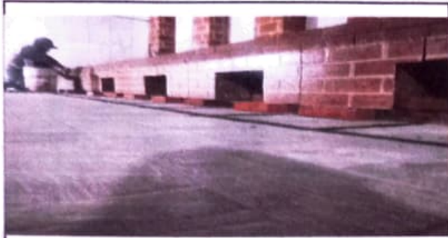
AVANCE DE COLOCACIÓN DE PISO
