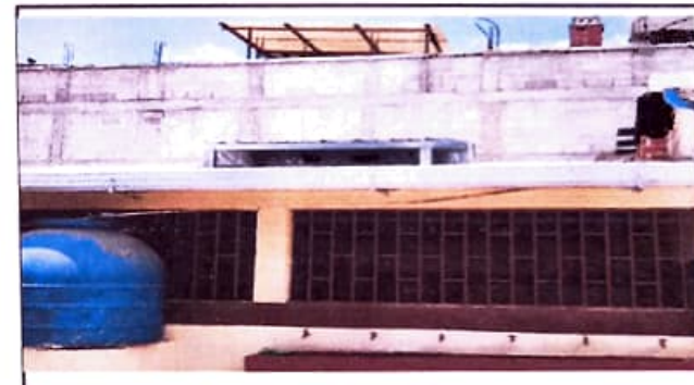
TERMINANDO EL ENTECHDO DE COCINA
