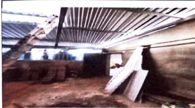
AVANCE DEL ENTECHADO
