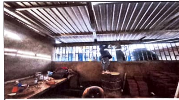
ASI ESTA QUEDANDO EL ENTECHADO
