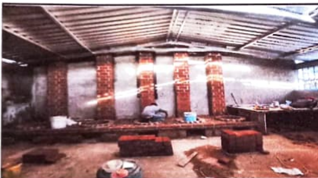
AVANCE DEL TRABAJO DE INTERIOR DE COCINA
