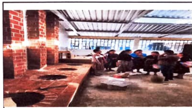
IMAGEN DEL TECHO Y DE ESTUFAS DE LADRILLO
