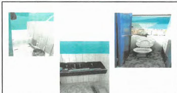
Mano de obra especializada ( Albañilería, Electricidad y Plomería)
