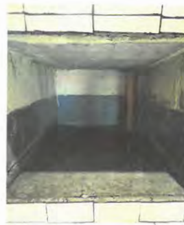
Foto 8: 19 Mano de obra especializada (Plomería) . Reparación de tubería de drenaje de cocina
