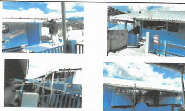
Canales y Bajadas de agua pluvial.
