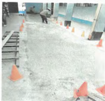
PISO Sustitución de piso de torta de concreto.
