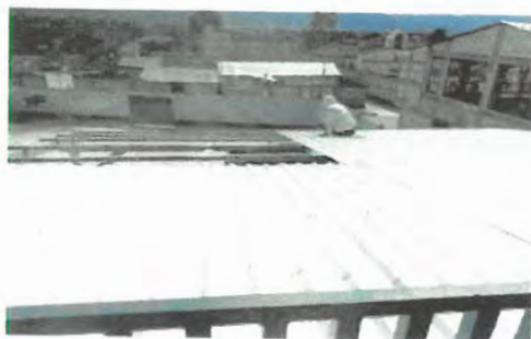
CUBIERTA DE LAMINA, Sustitución de lámina, por lámina troquelada aluzinc calibre 26.
