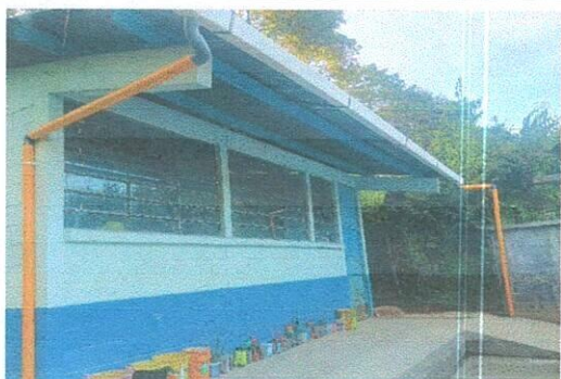
Foto 3: Aula 3 instalación de canal caudal y bajadas de agua pluvial
