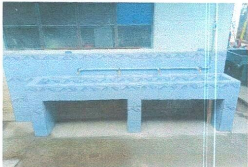
Foto 5: Sustitución de grifos e instalación de azulejo en lavamanos de concreto
