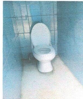
Foto 6: Sustitución de tazas y accesorios
