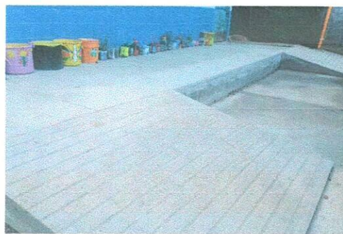
Foto 4: Reparación de plancha de concreto
