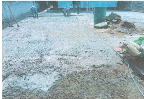
Foto 8: Sustitución de piso de torta de concreto
