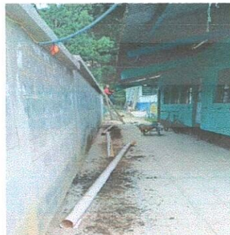
Foto 2: Aula 1 y 2 sustitución de tubo PVC por canal caudal y bajadas de agua pluvial
