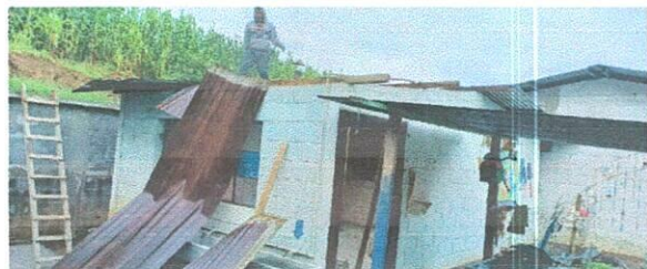
Foto 1: Área de sustitución de lamina acanalada por lamina troquelada incluye canalización de agua pluvial
