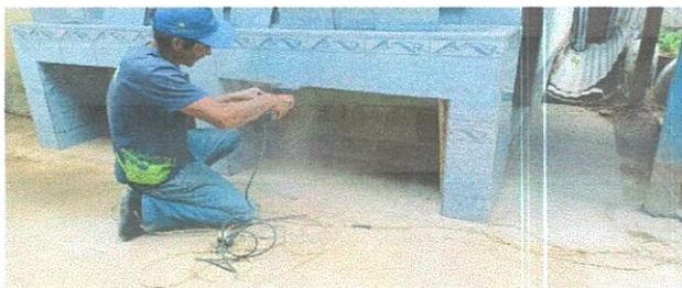
Foto 5: Sustitución de grifos e instalación de azulejo en lavamanos de concreto
