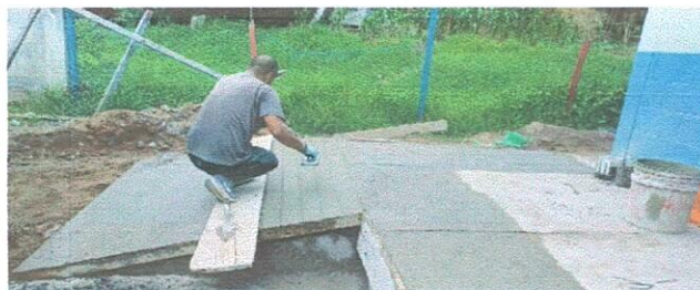
Foto 4: Reparación de plancha de concreto
