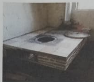
Mantenimiento a estufa Rural, que incluye azulejado y chimenea.
