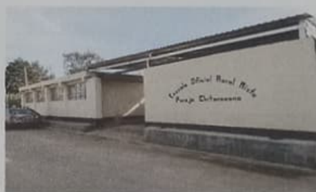
Pintura en muros Exteriores e Interiores
