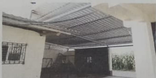
Sustitución de estructura de soporte de metal, por metal y lamina troquelada aluzinc calibre 26 en juegos infantiles
