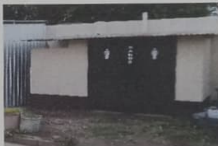
Nivelación de Puertas.
