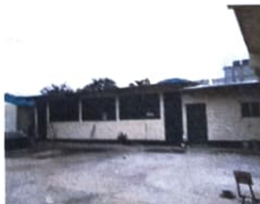
Pintura en muros Exteriores e Interiores
