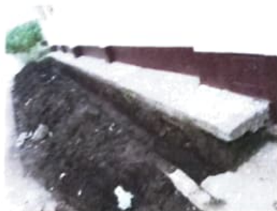
Reparación de banqueta de concreto
