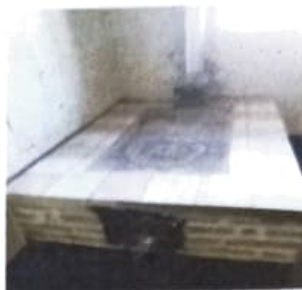
Mantenimiento a estufa Rural, que incluye azulegado y chimenea.
