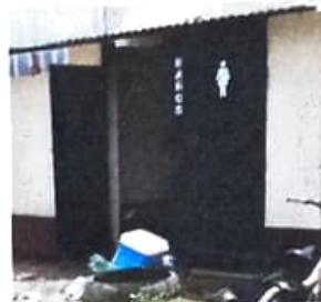
Mantenimiento a estructuras, puertas, chapas y nivelación de puertas.
