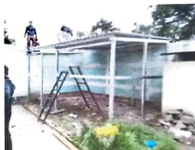
Sustitución de estructura de soporte de madera, por metal y lamina troquelada aluzinc calibre 26, bodega
