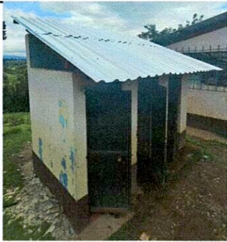
Foto 3: Techo de sanitarios cambiado
