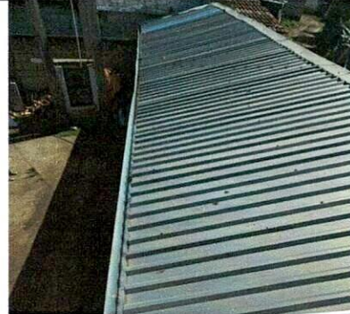
Foto 2: Canales instaladas.
