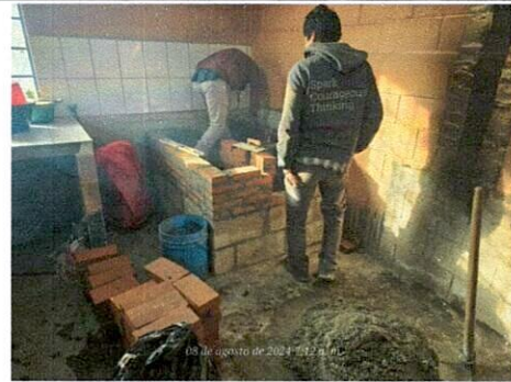
Foto 4: Mejoramiento de plancha
