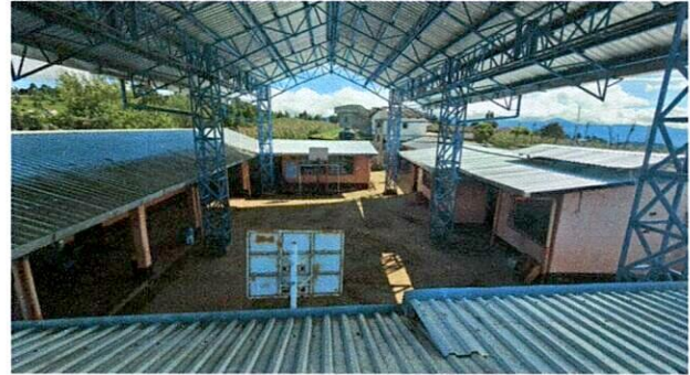
Foto 2: colocacion de canales
