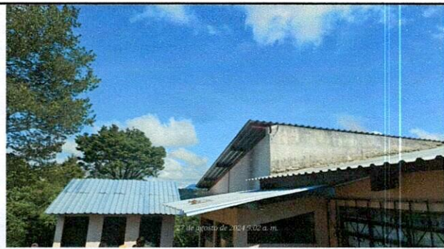
Foto 3: Techo de sanitarios
