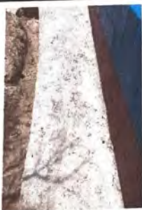
Foto 9: REMOZAMIENTO DE BANQUETA
