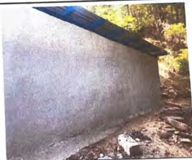
Foto 10: REPELLO EN MUROS EXTERIORES
