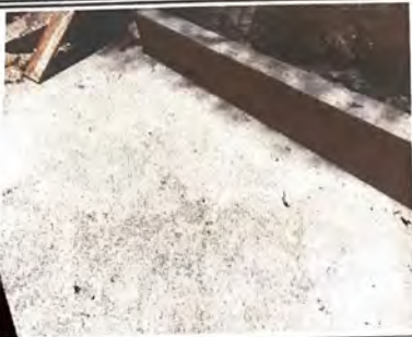
Foto 7: . PISO DE CONCRETO
