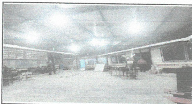
Foto 5: Instalación de sistema eléctrico en todo el centro educativo, trabajo finalizado en un porcentaje de 100%
