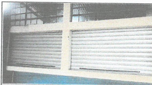
Foto 3: Instalación de 2 persianas, trabajo finalizado en un 100%
