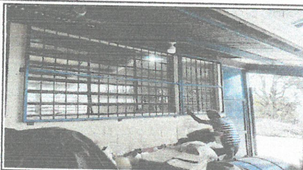
Foto 2: Instalación de 8 balcones de momento, falta completar los 12 balcones (porcentaje de trabajo realizado 80%)
