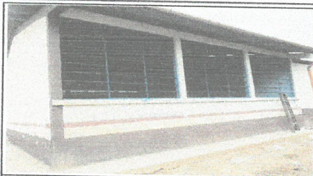
Foto 1: Instalación de ventanas, falta instalación de vidrios en la misma (porcentaje de trabajo realizado 50%)
