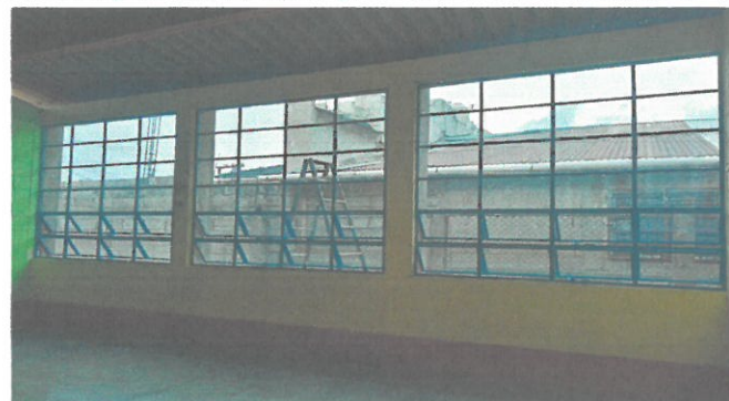
VISTA DE VENTANALES REMOZADA
