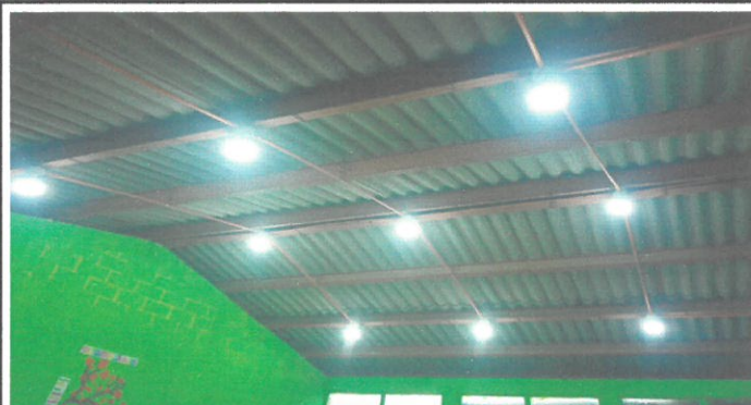
VISTA DE RED ELECTRICA REMOZADA
