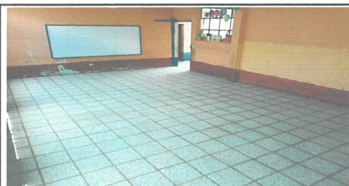
VISTA DE PISO DE AULA REMOZADA
