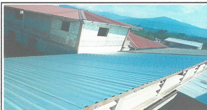
VISTA DE TECHO REMOZADO
