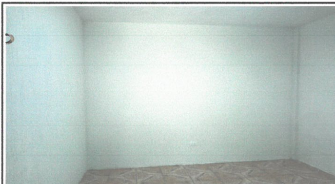
VISTA DE BODEGA REMOZADA
