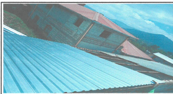
VISTA DE TECHO REMOZANDO
