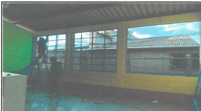
VISTA DE VENTANALES REMOZANDO
