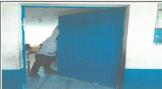
VISTA DE PUERTA REMOZANDO
