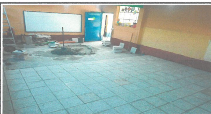
VISTA DE PISO DE AULA REMOZANDO
