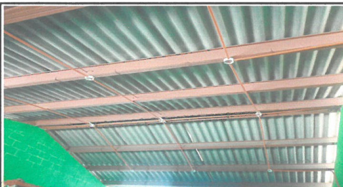
VISTA DE RED ELECTRICA REMOZANDO
