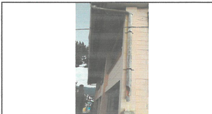
Foto 6: SUSTITUCIÓN DE TUBO DE AGUA PLUVIALES
