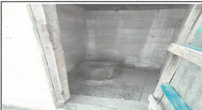
Foto 3: SUSTITUCIÓN DE LETRINAS E INSTALACIÓN DE BAÑOS LAVABLES
