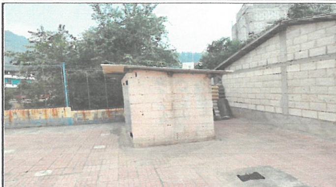
Foto 2: SUSTITUCIÓN DE POZO CIEGO POR SISTEMA BIODIGESTORIO
