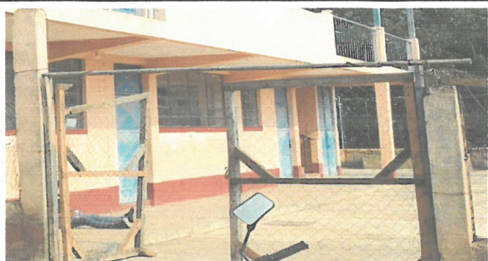
Foto 1: SUSTITUCIÓN DE PORTON DE MAYA A PORTON METALICO
