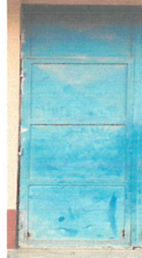
Foto 8: APLICACIÓN DE PINTURA ANTICORROSIVAS A PUERTAS
