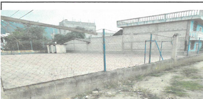
Foto 5: SUSTITUCIÓN DE MALLA ACTUAL POR MALLA GALVANIZADA CON MARCOS METALICOS.
