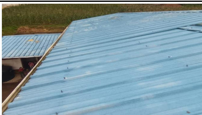
Foto 4: Cambio de tornillos del techo de las aulas del segundo nivel porque ya están muy resacos y oxidados.
