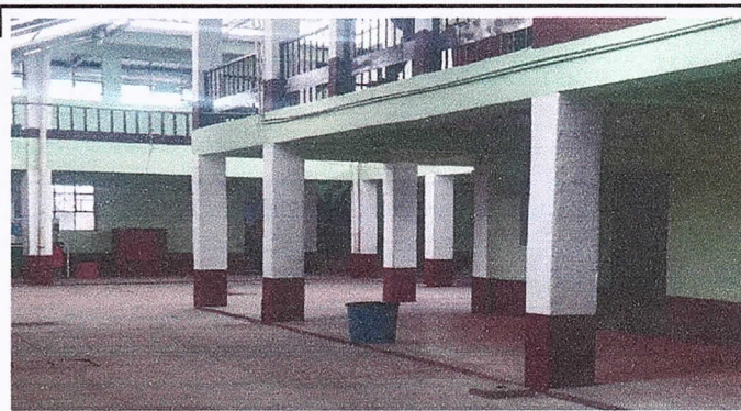
Foto 2: VISTA DE PARED Y COLUMNAS INTERIORES DESPUES DE PINTAR
