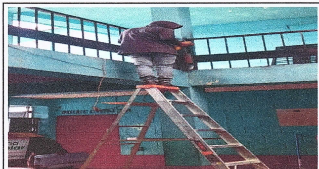
Foto 5: VISTA DE LAS BARANDAS DURANTE LA PINTADA
