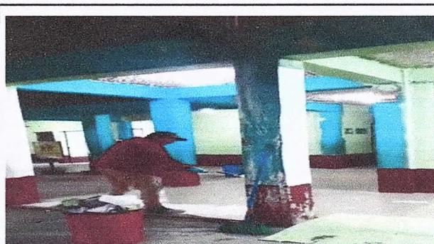
Foto 2: VISTA DE PARED Y COLUMNA INTERIOR DURANTE LA PINTADA
