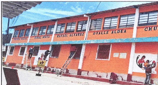
Foto1: VISTA DE LA PARED EXTERIOR DURANTE LA PINTADA
