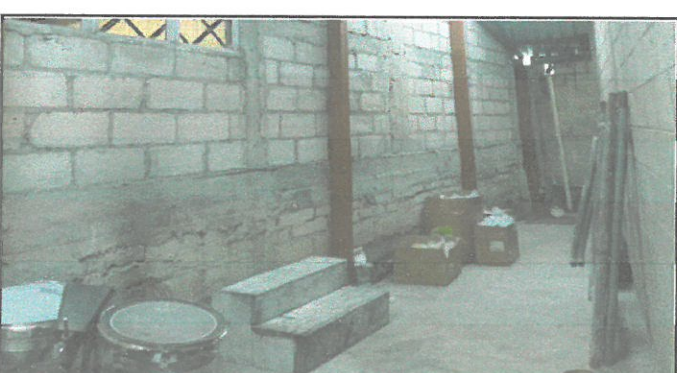
Foto 6: Renglón 6 Drenaje: Retiro de pavimento, y colocación de reposadera, colocación de tubería para mingitorio, acondicionamiento de caja de drenaje, y tubería auxiliar para canal de cocina.
