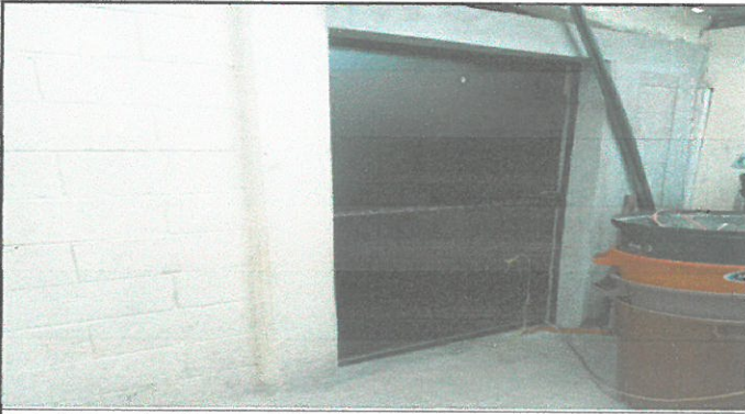
Foto 9: Renglón 9 Puerta: Retiro de puerta de metal
