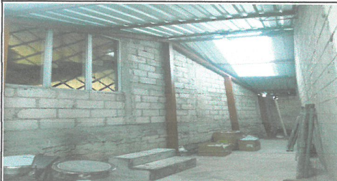
Foto 1: Renglón 1 Techos: Instalación de lamina de bodega y cocina y pasillos de baños
