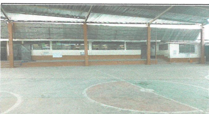
Foto 4: Renglón 4 Pintura Aplicación de pintura en parales
