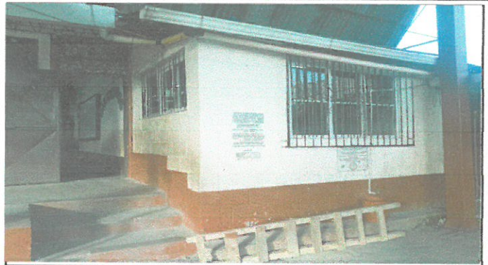
Foto 8: Renglón 8 Ventana: Retiro e instalación de ventanas
