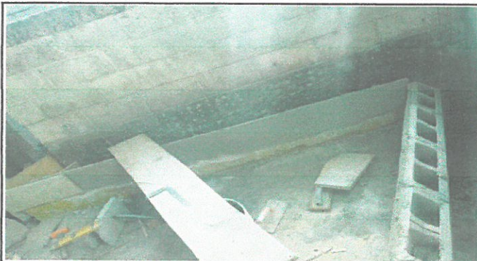
Foto 7: Renglón 7 Paredes: remodelación de paredes de bodega, y azulejo para pared de baño mingitorio
