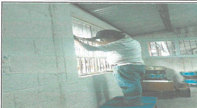
Foto 8: Renglón 8 Ventana: Retiro e instalación de ventanas
