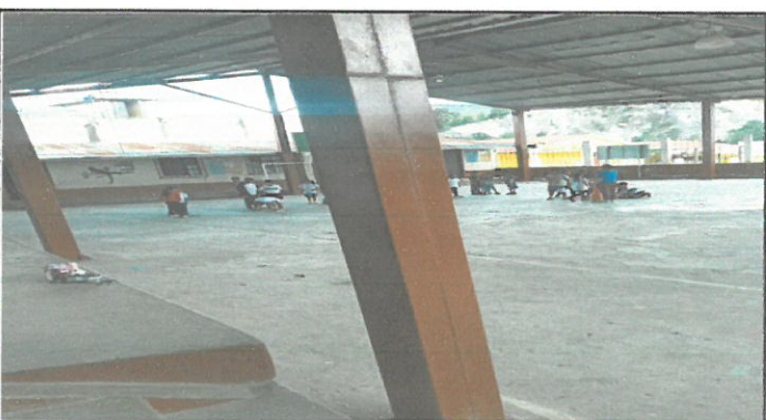
Foto 4: Renglón 4 Pintura Aplicación de pintura en pares
