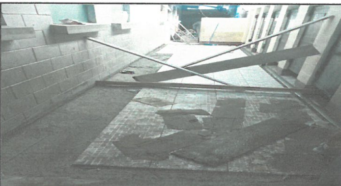
Foto 3: Renglón 3 Piso: Relleno con selecto y torta de concreto con mezción y piso, en bodega, cocina y baño, tallado de bordillo en baños.
