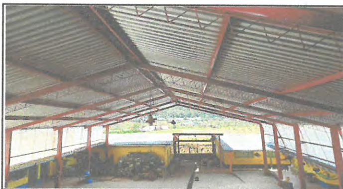
Foto 4.1 PINTADA DE ESTRUCTURA METALICA DEL PATIO DE LA ESCUELA PILARES, COSTANERAS Y VIGAS
