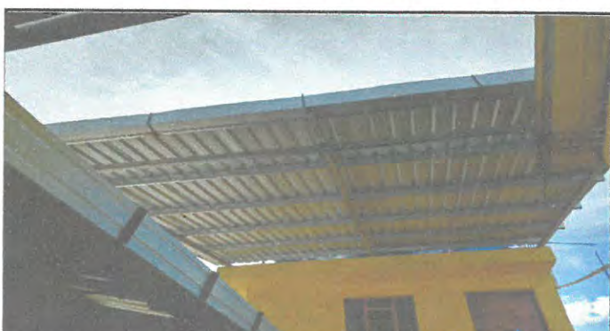
Foto 1.3 Foto 1.3 SUSTITUCION DE ESTRUCTURA DE MADERA POR ESTRUCTURA METALICA DE COSTANERAS,VIGAS Y LAMINAS TROQUELADA CALIBRE 26 ALA PAR DE LA BODEGA
