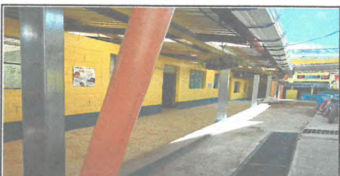
Foto 2.1 SUSTITUCION DE 6 PILARES Y UNA VIGA DE MADERA POR METAL GALVANIZADO EN CORREDOR FRENTE A TRES AULAS
