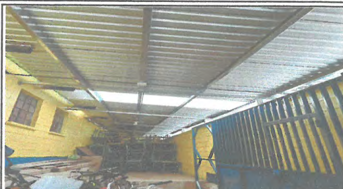
Foto 1 .2 SUSTITUCION DE ESTRUCTURA DE MADERA POR ESTRUCTURA METALICA DE COSTANERAS, VIGAS Y LAMINAS TROQUELADA CALIBRE 26 EN EL PASILLO DETRÁS DE LOS SERVICIOS
