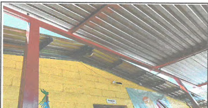
Foto 5.1 SUSTITUCION DE SISTEMA ELECTRICO EN 6 APAGADORES Y 8 TOMACORRIENTES PARA CUATRO AULAS, SISTEMA ELECTRICO DE TIMBRE DE LA DIRECCION CAJA DE MADERA DE FLIPON DE LINEA
