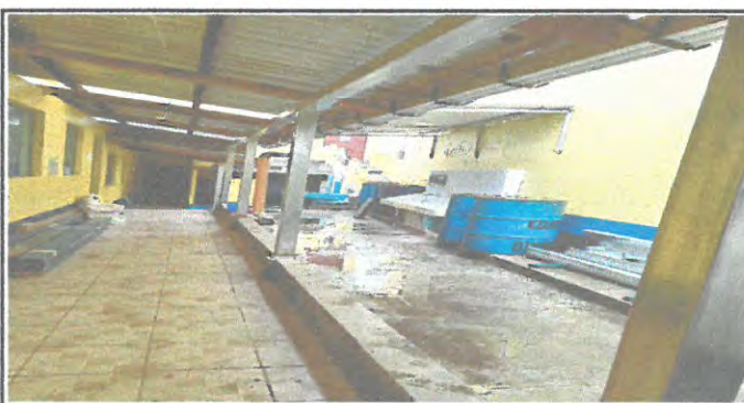
Foto 2.1 SUSTITUCION DE 6 PILARES Y UNA VIGA DE MADERA POR METAL GALVANIZADO EN CORREDOR FRENTE A TRES AULAS
