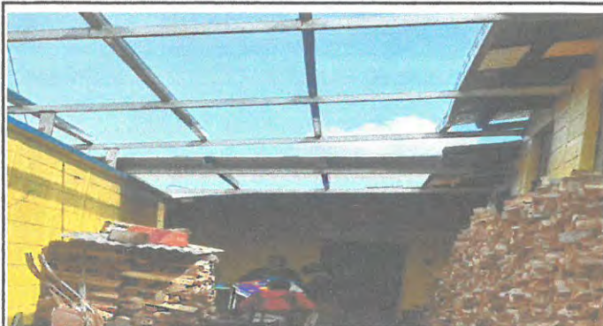
Foto1 .1: SUSTITUCION DE ESTRUCTURA DE MADERA POR ESTRUCTURA METALICA DE COSTANERAS,VIGAS Y LAMINAS TROQUELADA CALIBRE 26 EN EL PASILLO HACIA LA COCINA
