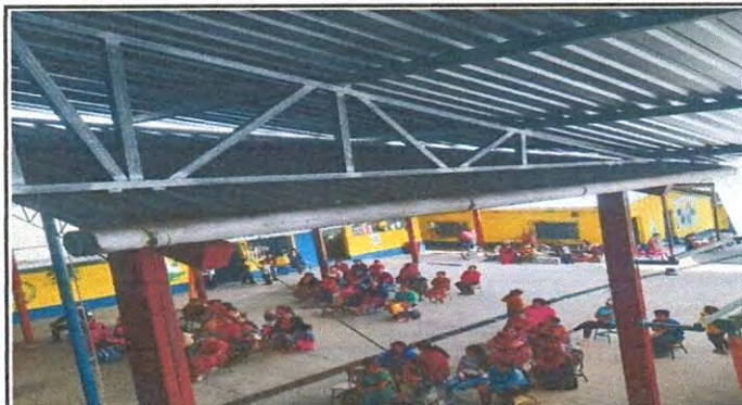
Foto 3.2 SUSTITUCION DE CANALES COLECTORES DE AGUAS PLUVIALES,POR VAJADA DE AGUA DE METAL CON PESCANTE LADO IZQUIERDO DE PATIO DE LA ESCUELA
