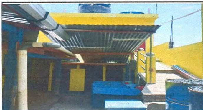
Foto 3.1 SUSTITUCION DE CANALES COLECTORES DE AGUAS PLUVIALES,POR VAJADA DE AGUA DE METAL CON PESCANTE FRENTE A CINCO AULAS
