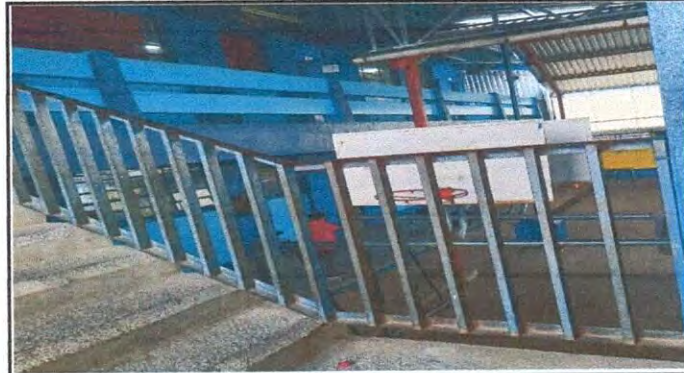
Foto 4.2 PINTADA DE BARANDAS EN GRADAS HACIA SEGUNDO NIVEL
