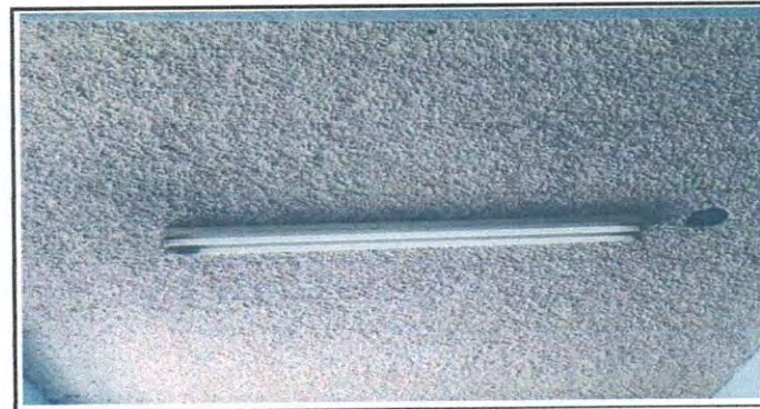
Foto 5.1 SUSTITUCION DE SISTEMA ELECTRICO EN 6 APAGADORES Y 8 TOMACORRIENTES PARA CUATRO AULAS,SISTEMA ELECTRICO DE TIMBRE DE LA DIRECCION CAJA DE MADERA DE FLIPON DE LINEA
