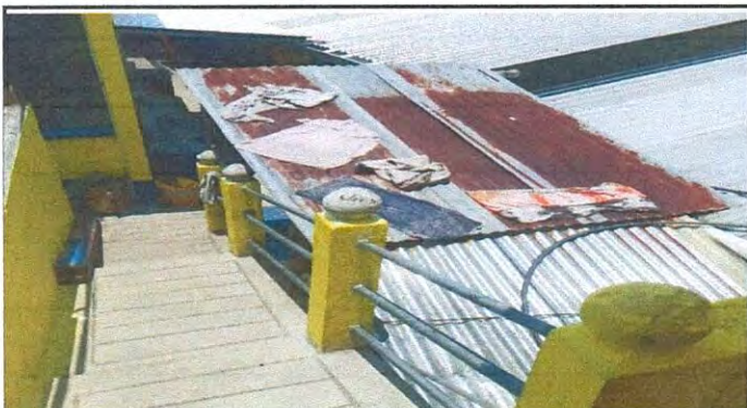
Foto 1.3 SUSTITUCION DE ESTRUCTURA DE MADERA POR ESTRUCTURA METALICA DE COSTANERAS,VIGAS Y LAMINAS TROQUELADA CALIBRE 26 ALA PAR DE LA BODEGA
